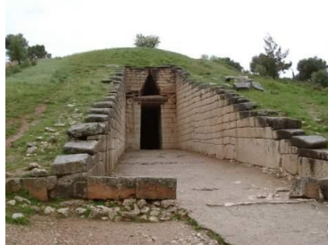
Abb.: 14. Realaufnahme des flachen Zugangs
